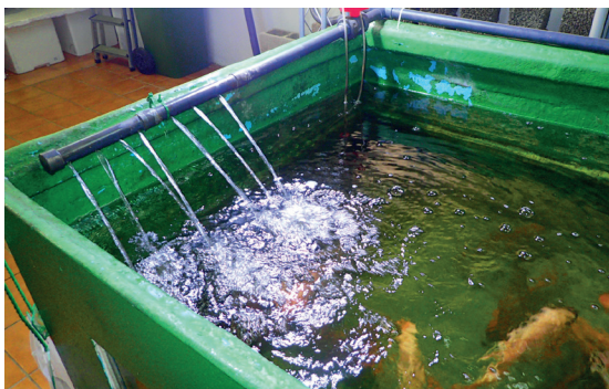
Bomba de agua funcionando correctamente / Water pump working properly
