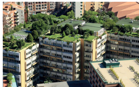
Techo verde en de Toronto (Canadá) / Green roof in Toronto (Canada)
